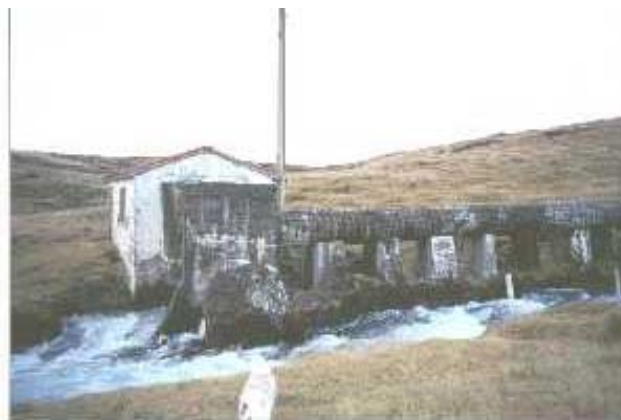
Mynd 17. Stöðvarhús Eyvindartungu
