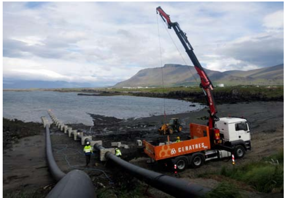
Í fjörinni í Höfðavík er nú unnið að því að festa steinsteypa klossa á leiðsluna sem eiga að halda henni á hafsbotni. Auk þessa veður leiðslan grafin niður að hluta en einnig fest með akkerum sem fest verða við botninn.
