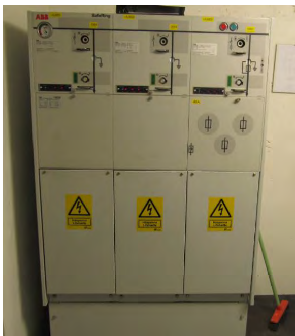
Mynd 2 Háspennurofasett í rofastöð
