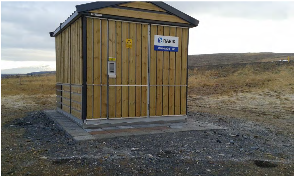
Mynd 1 Hússpennistöð með háspennurofum
